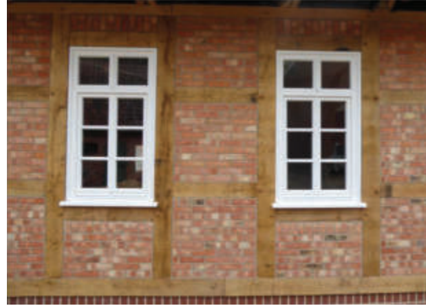
Abb. 77 Beispiele: Neue Dachgaube mit Fenstern und Holzverschalung, erneuerte Fachwerkfassade
