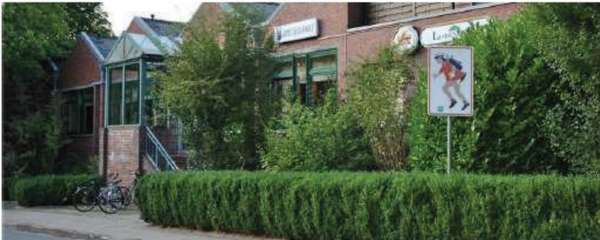
Abb. 50 Ansicht Eingang des DGH
