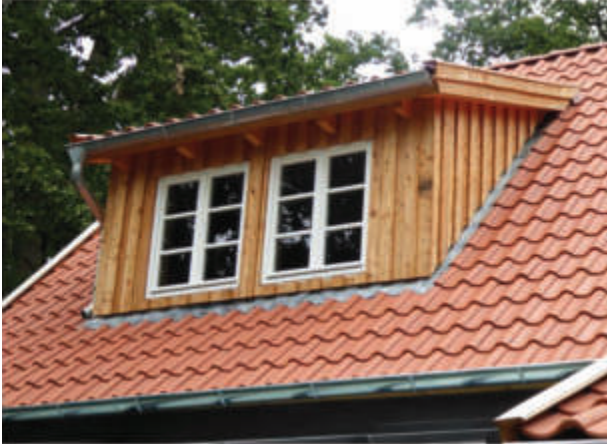
Abb. 77 Beispiele: Neue Dachgaube mit Fenstern und Holzverschalung, erneuerte Fachwerkfassade
